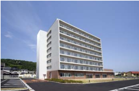
若松工場独身寮完成(2009年4月5日)
