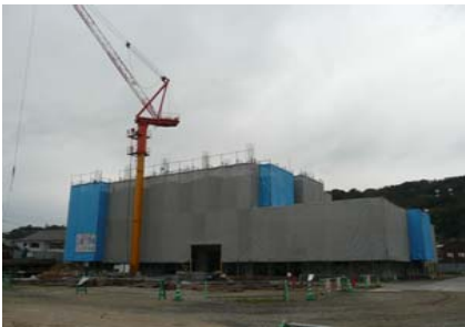
建設中の若松工場独身寮
