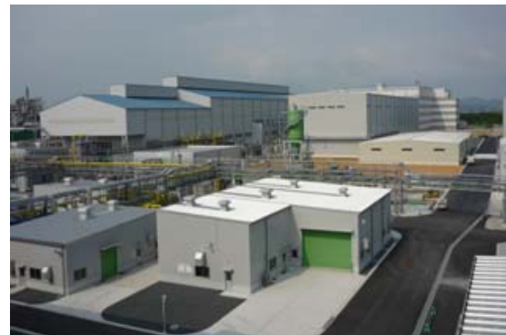
若松工場建設現場写真 (2009年7月30日撮影)
