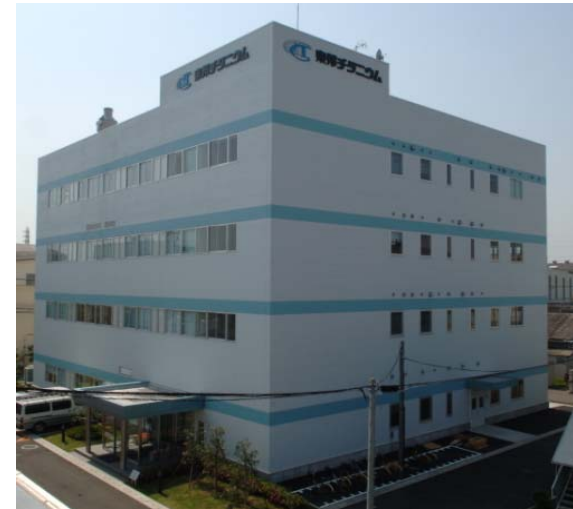
2007年に完成した新研究開発棟
