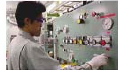
スラリー重合棟の重合装置
