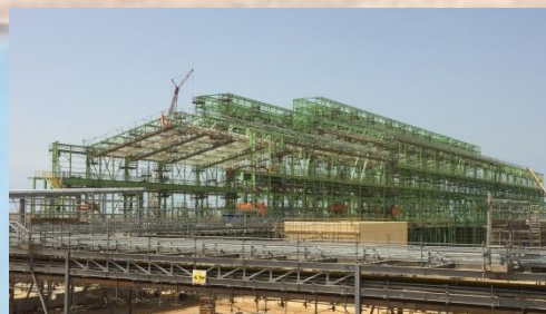
建設中のサウジアラビアスポンジ製造工場
