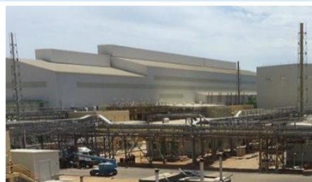
サウジアラビアのスポンジ工場外観
