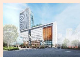
JR横浜タワーの外観イメージ（建設中）
