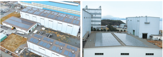
若松工場内で設置した太陽光発電パネル https://www.toho-titanium.co.jp/csr/data/ ※Power Purchase Agreementの略。発電事業者が敷地内外への発電設備の設置と運用・保守を実施、発電した電力を需要家に供給する電力購入契約。
